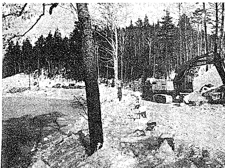
Arbetet med den sista etappen, Somvik—Sjöbo, har pågått hela vintern och trots tidsschemat. Lagom till sommaren kommer hela vägen mellan Boxholm och M. belagd med oljegrus.
