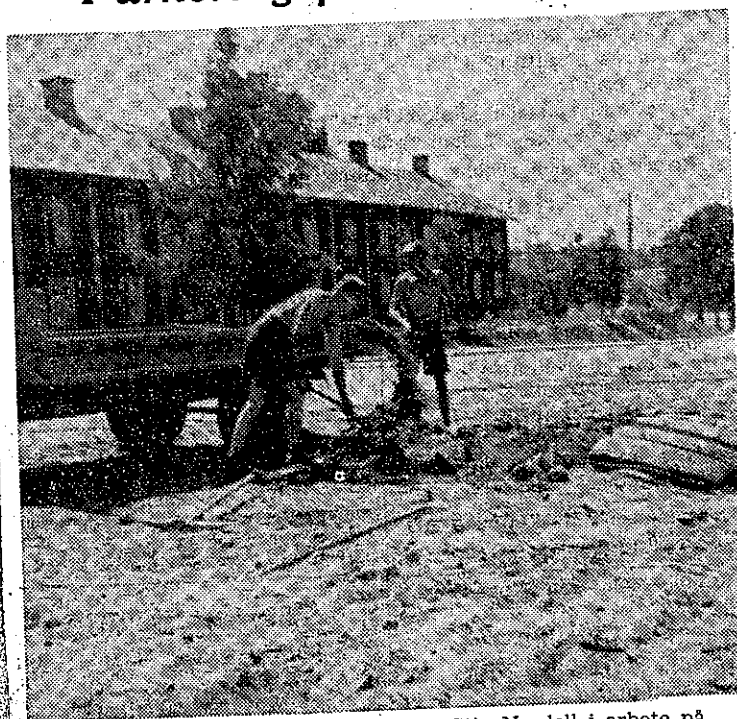
Vägarbetarna Knut Johansson och Stig Nordell i arbete på parkeringsplatsen
