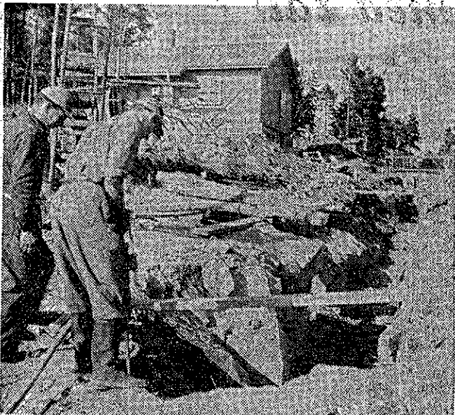
Gatan och ledningarna har fått sprängas ner många meter i berg. Här är Knut Johansson och Stig Nordell i sprängningstagen
