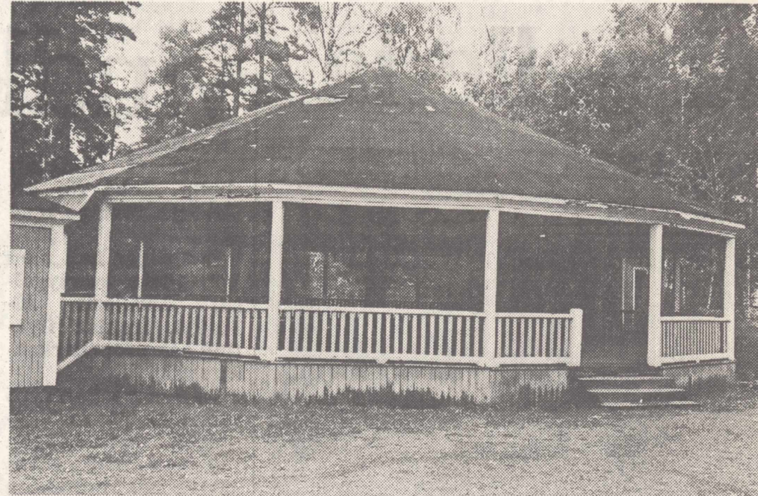
Upprustningen av Folkets park är ett av undantagen inom Boxholms kulturminnesvård anser studenterna vid Stockholms universitet
