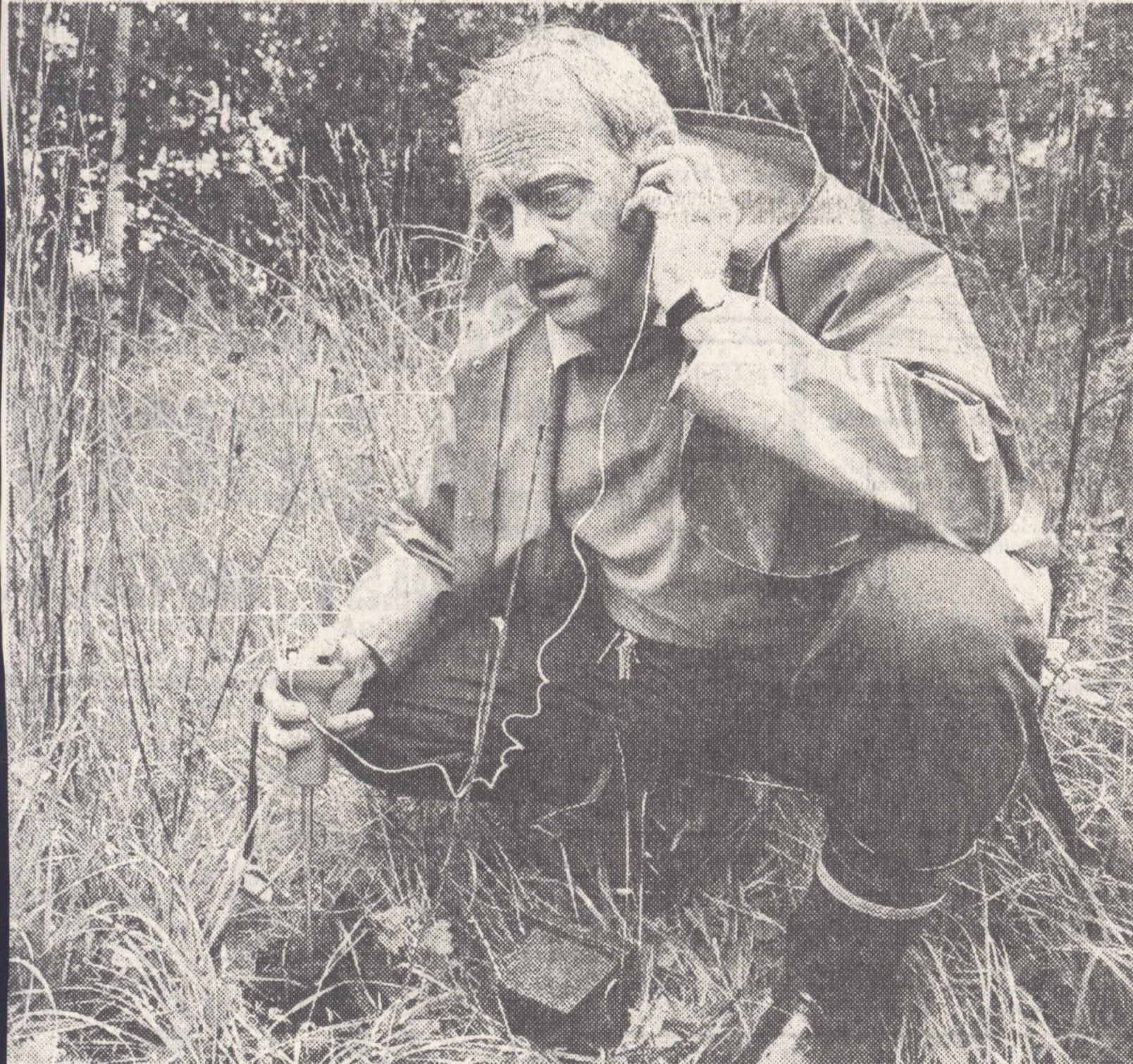
Med ett elektroniskt instrument har Conny Abrahamsson undersökt ventiler och ledningar för att undersöka om det är några onormala brusljud som skvallrar om att det finns en större läcka i området, men utan resultat
