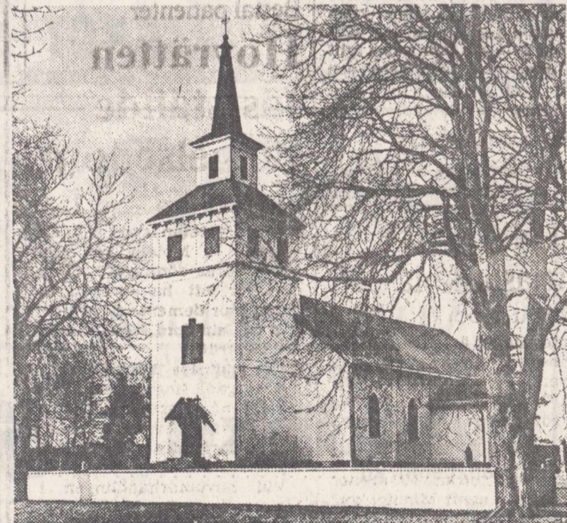
Träden vid kyrkogårdsmuren kommer att fällas när kyrkan i Blåvik renoveras
