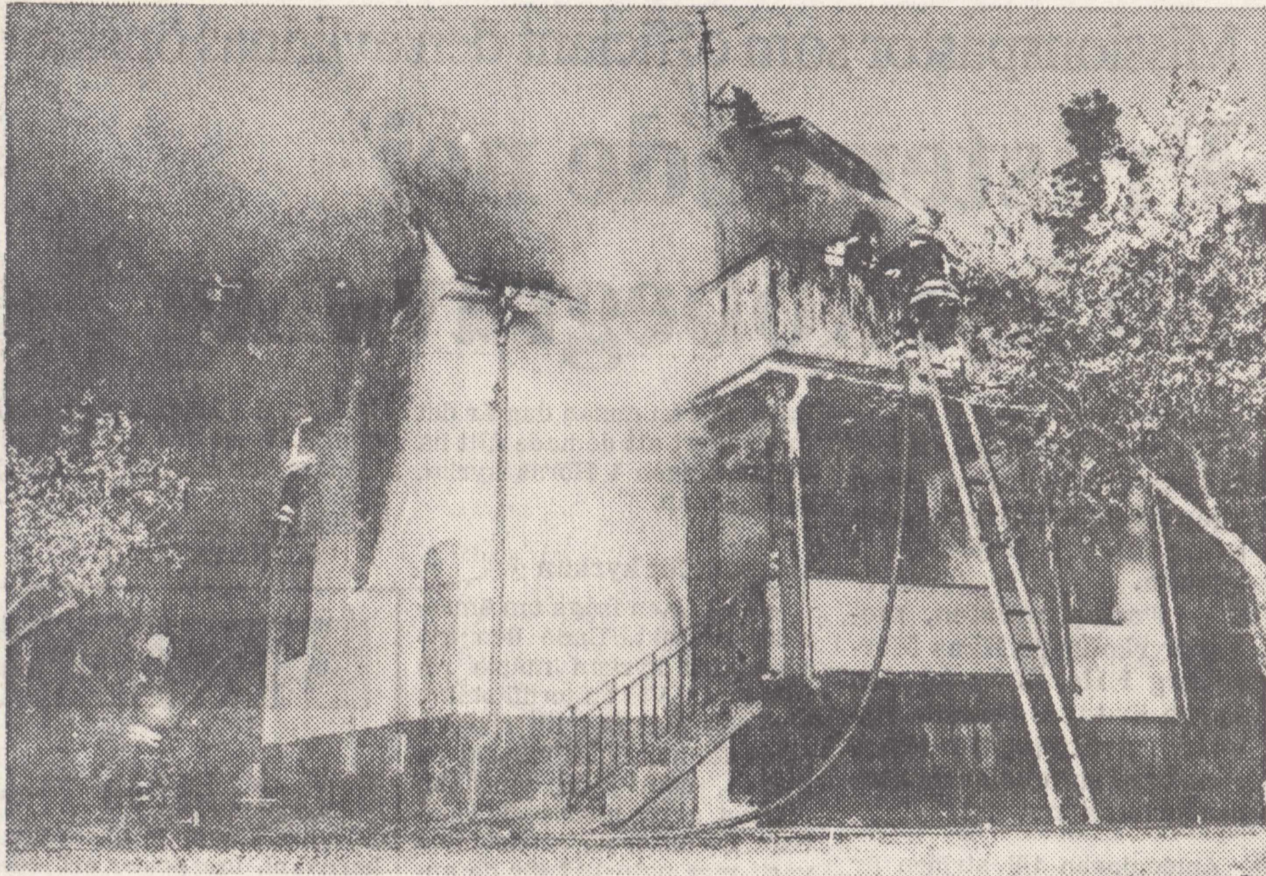
Villan blev totalt utbränd och ännu långt fram på lördagen pågick släckningsarbetet
