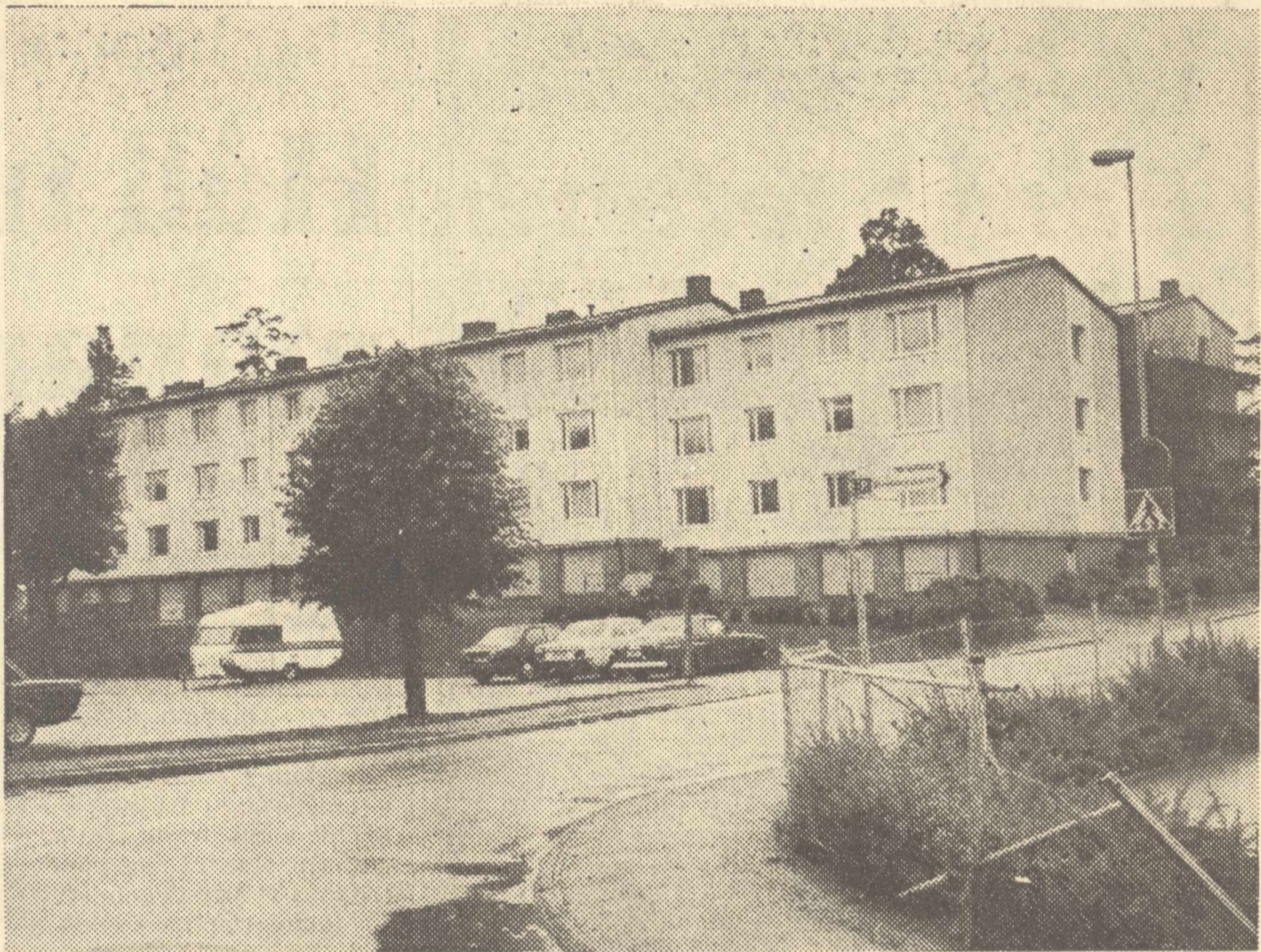
Eternitplattorna på Riksbyggens husväggar på Pehr Hannergeratan ersätts i sommar med fasadtegel i kalksandsten. På huset på bilden är omklädnaden klar. På de tre andra pågår arbetet
