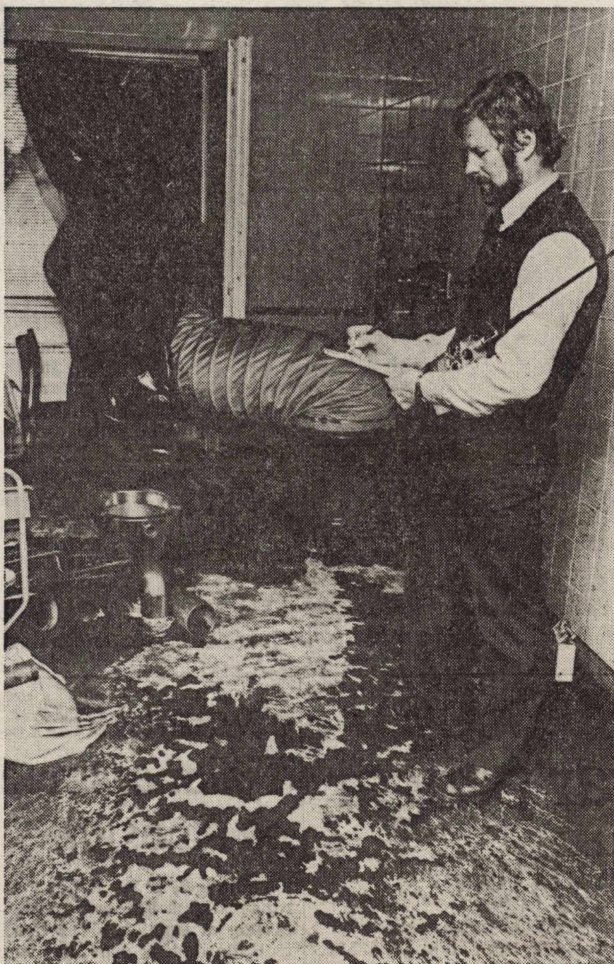
Vice brandchef Bengt-Åke Holmberg betraktar förödelsten i duschutrymmet ovanför utrymmet där branden började
