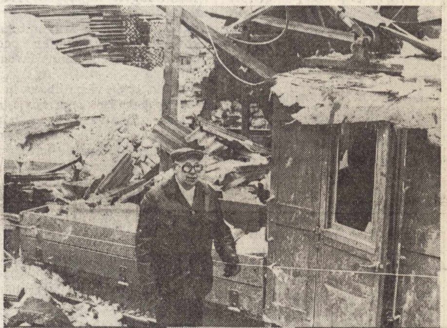
77-årige Kalle Stenqvist betraktar förödelsen vid bruksmuseet. Sedan pensioneringen för drygt 10 år sedan har museet varit hans skötebarn. På bilden betraktar han skadorna på samlingens dyrgrip, Sveriges första elektrifierade lok från 1890
