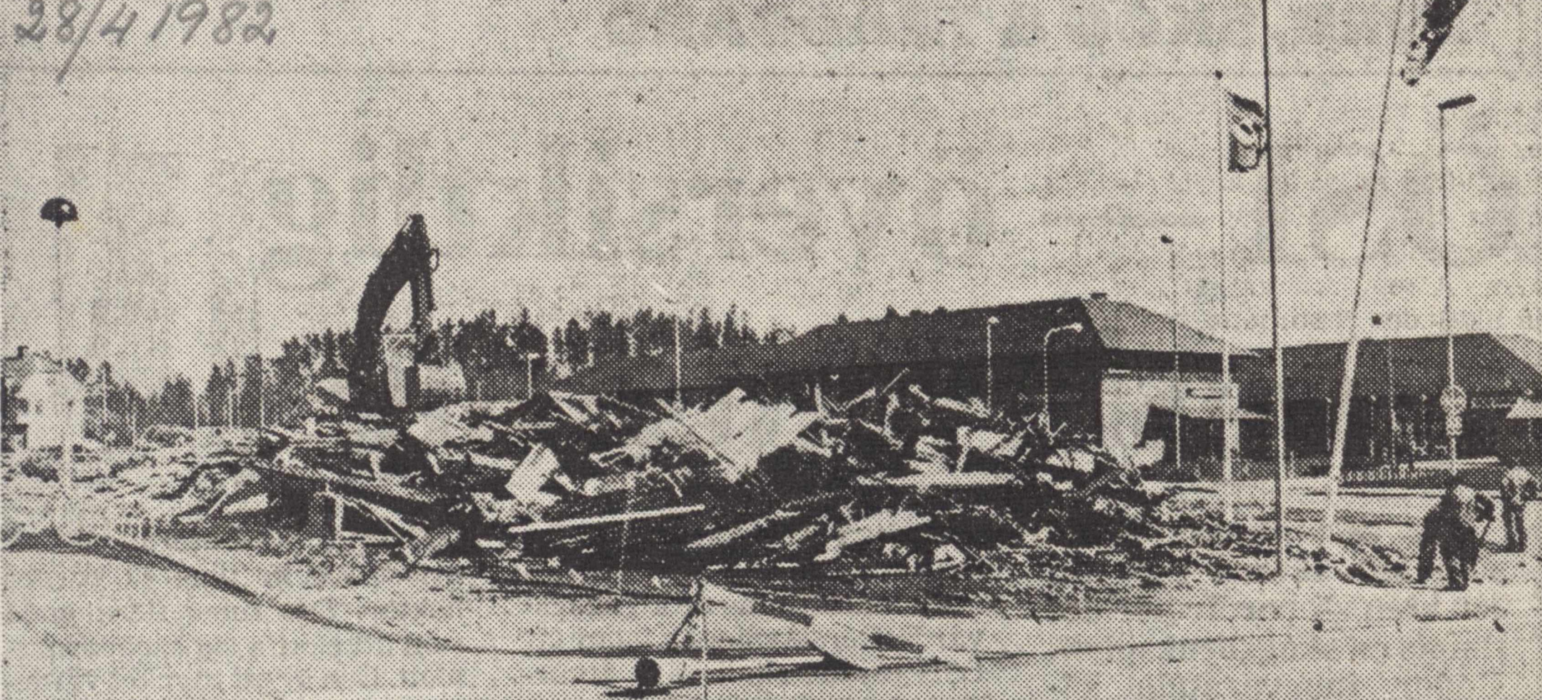
En ersättningsmaskin kördes fram till rivningsplatsen sedan olyckan hänt. Med Sören Eriksson bakom spakarna fullföljdes rivningen på måndagen
