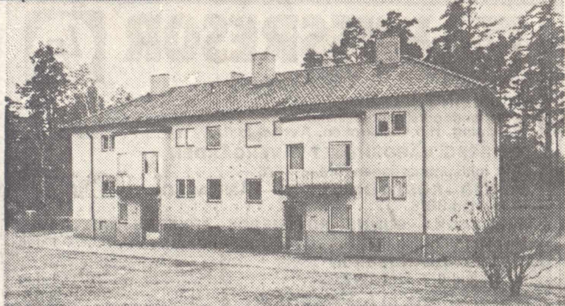
Kommunstyrelsen har beslutat att riva pensionärsbostäderna på Malexandervägen. Här är ett av de båda husen
