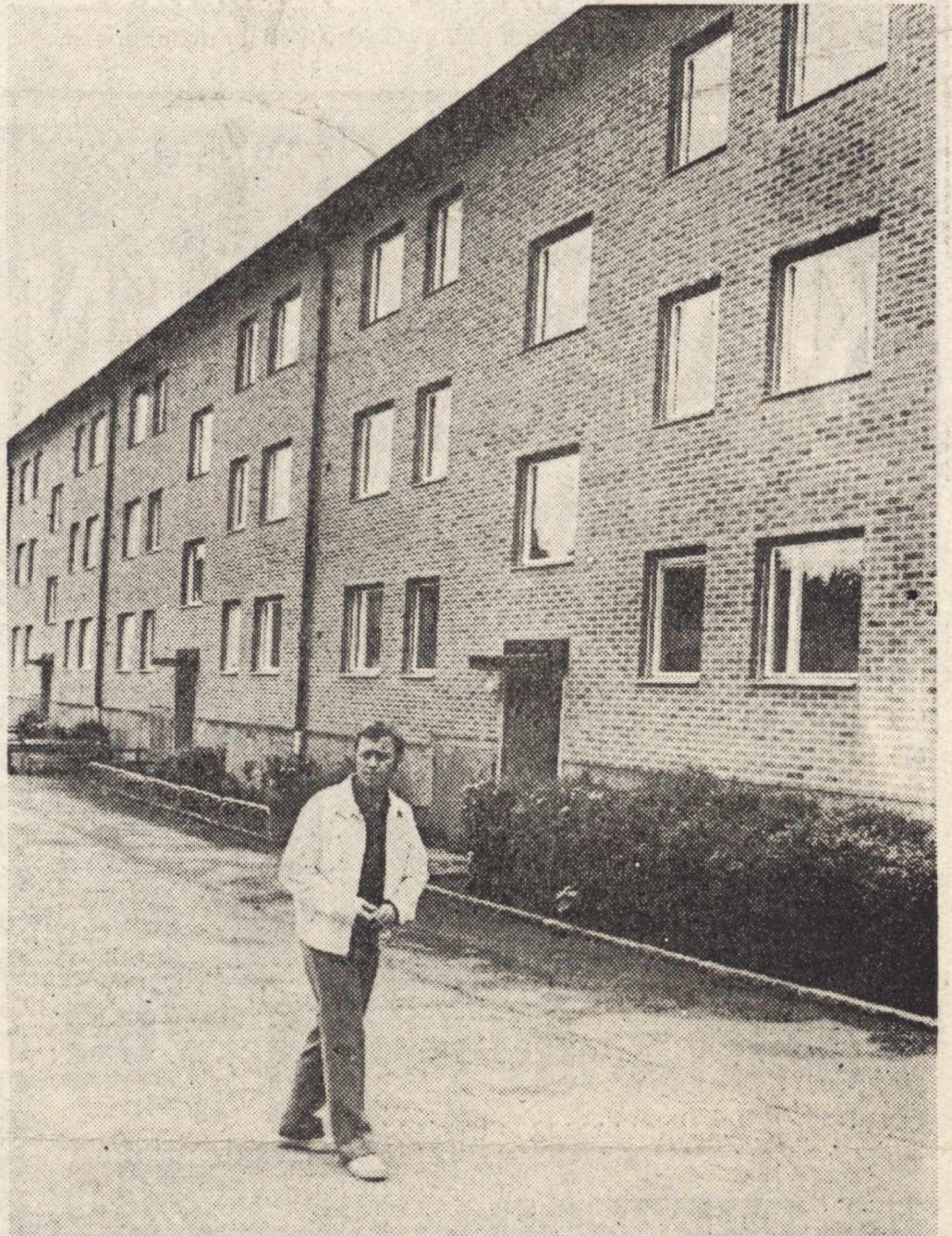
Bjursdalsvägen 17 byggs om efter semestern och skall bli inrymma sex handikapplägenheter. Lennart Hultgren på AB Boxholmshus demonstrerar
