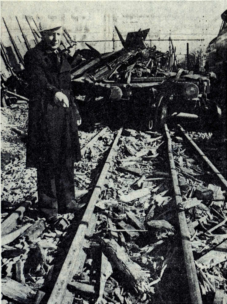
Det kommer att dröja innan spåret för de norrgående tågen är klart, säger röjningschefen Knut Strömbergsson. Övertidsblockaden gör att arbetet kanske tar en vecka
