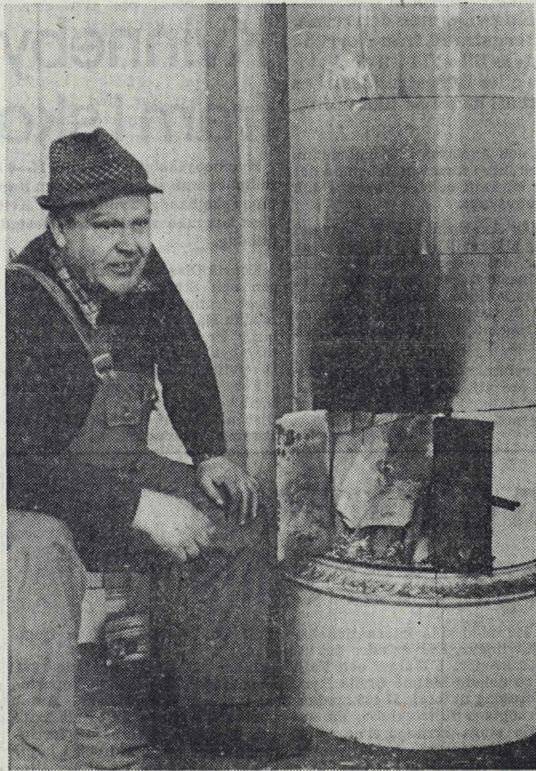
Tage Tybring, Boxholm, som river fastigheten, har själv köpt ett par av kakelugnarna. Den enda som finns kvar, den ovanligt smala 24-tummaren, använder han att värma sig vid under rivningen. Alla de övriga är redan nedmonterade
