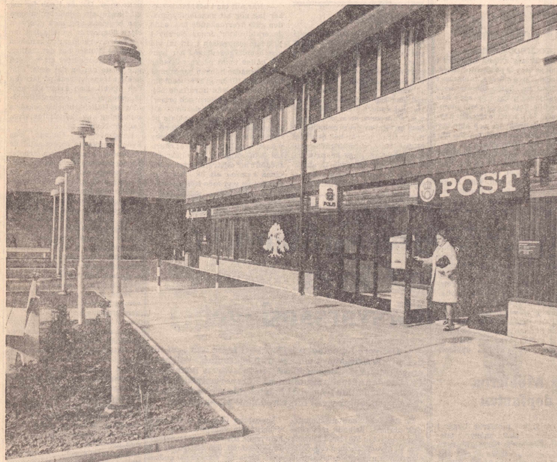
Boxholms nya Centrumhus har blivit ett verkligt servicecentrum där det mesta som tarvas i ett modernt samhälle samlats på en plats
