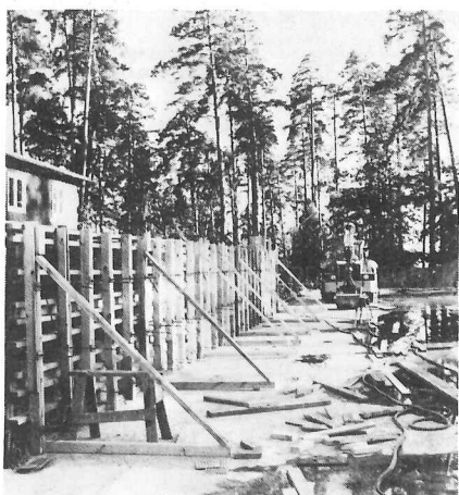
Gjutning av stödmur vid det befintliga mejeriet. (79-06-20)
