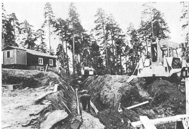
Armering av kabel för 10 KvA kablar som ligger under kyllagrets grundplatta. (79-05-14)
