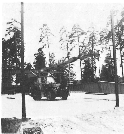
Intransport och resning av takstolar. (79-07-16)
