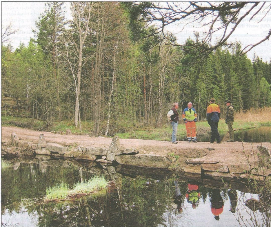
Den gamla stenvalvsbron såg kanske vackrare och lummigare ut innan renoveringen drog i gång i höstas, men arbetet är förstås viktigt om bron ska leva vidare.
