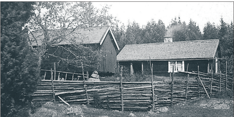
Enligt boken Sveriges bebyggelse är nuvarande stuga vid Tvärsjömålen uppförd 1925 och restaurerad 1946. Årtalet 1925 verkar underligt, men att det gjordes en större omdaning 1946 kan vi nog vara säkra på, det var strax efter att Johanna lämnat Tvärsjömålen. Johanna lär säkerligen ha fötts och växt upp i den gamla stugan som ses på denna bilden.
