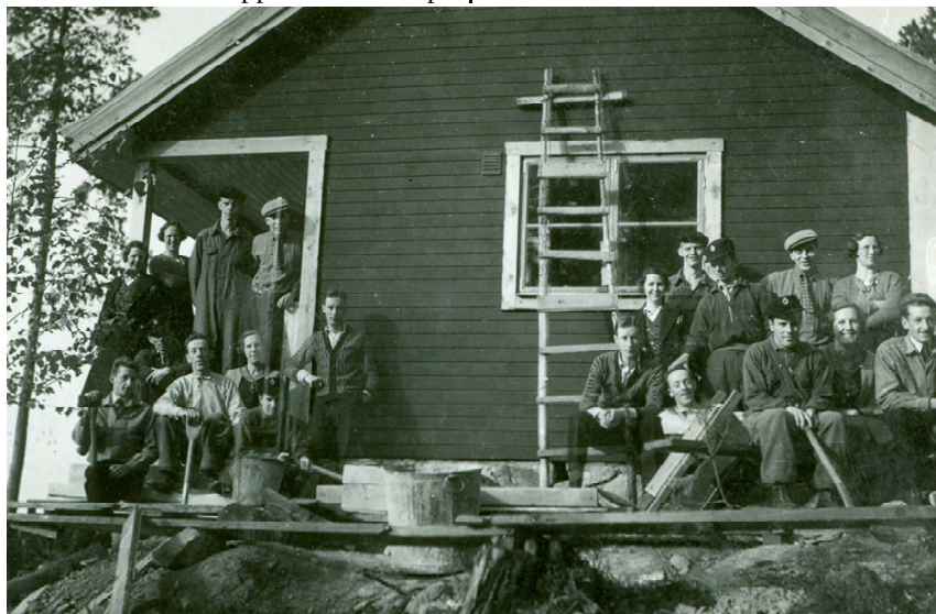
OK-stugan vid sjön Sommen började att byggas 1937. På bilden ses ett gäng stug-byggare samlade vid stugans gavel.
