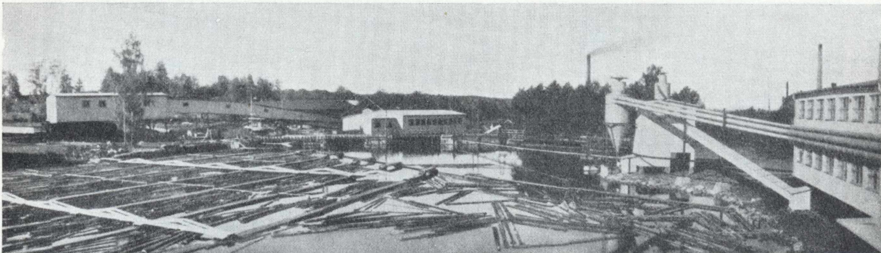
Vy från dammen ovanför Bruksfallet i Boxholm. Från vänster: sorteringsverket, sågverket med hyvleriet därbakom, ångcentralens skorsten, spån- och vedhus, snickerifabriken.
